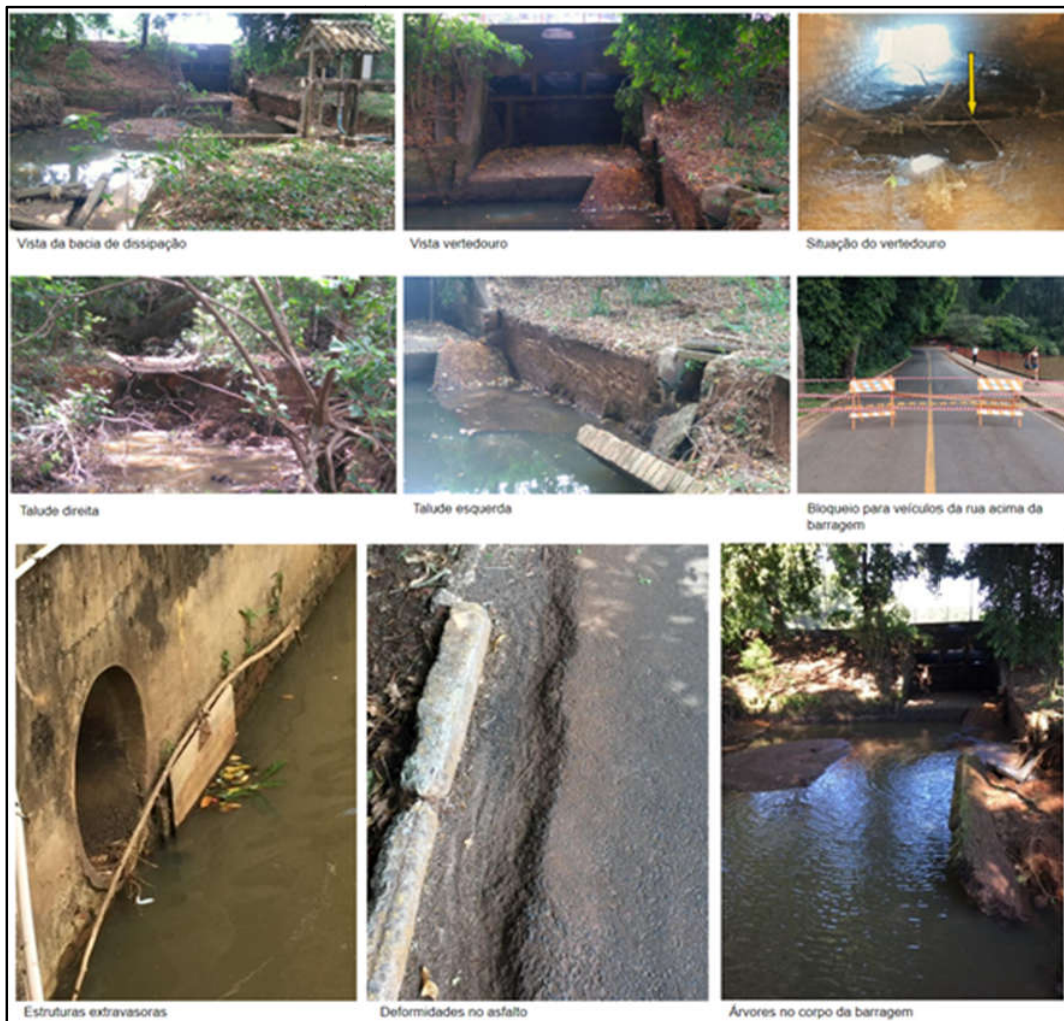
Figura 2: Mosaico de fotos retiradas para a classificação da barragem do monjolinho quanto à categoria de risco e ao dano potencial associado - estudo de caso. Fonte: POVINELLI, 2017.
